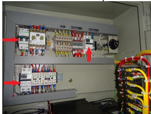
Fig.3: Painel da proteção com os disjuntores BT ligados
